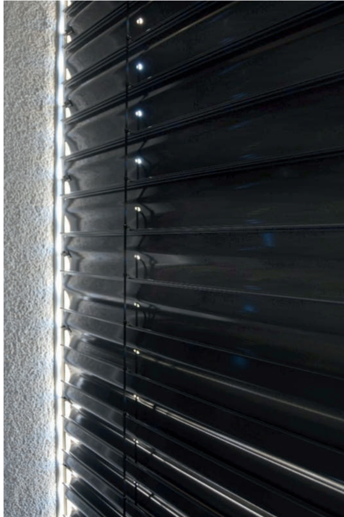
Bild 4. Zulässiger Streulichteinfall über die seitliche Führung
