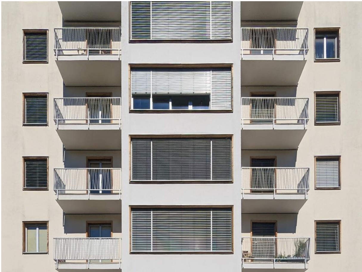
Raffstores an einem Wohngebäude der Zwischenkriegszeit in einer Schutzzone. Der Einbaukasten wurde im Zuge einer Fassadensanierung überputzt, die Konstruktion ist dadurch kaum sichtbar. Der Sonnenschutz ist an der Fassade einheitlich gestaltet.
