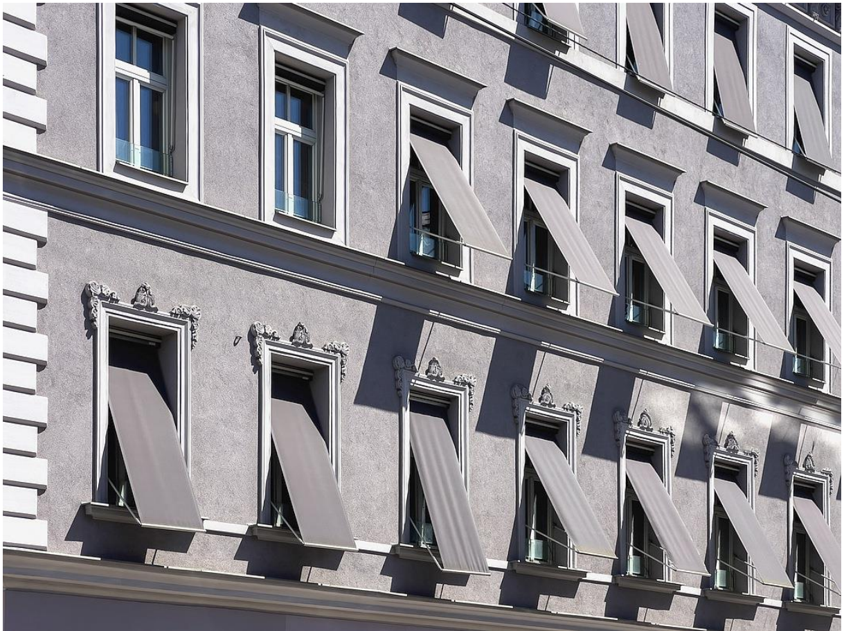
Bewilligungsfreie Fallarmmarkisen an einem dekorierten Gründerzeithaus außerhalb von Schutzzonen. Der eckige Vorbaukasten findet in der Fensterlaibung Platz, die Konstruktion wird in Fensterfarbe ausgeführt. Der Textilbehang ist in Fassadenfarbe gestaltet. Der Sonnenschutz ist an der Fassade einheitlich gestaltet.
