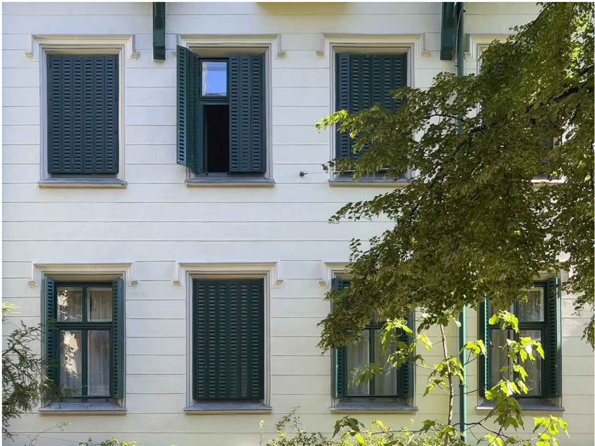
Faltläden an einer dekorierten Gründerzeitvilla in einer Schutzzone. Die Faltläden sind in Fensterfarbe gestaltet. Der Sonnenschutz ist an der Fassade einheitlich gestaltet.
