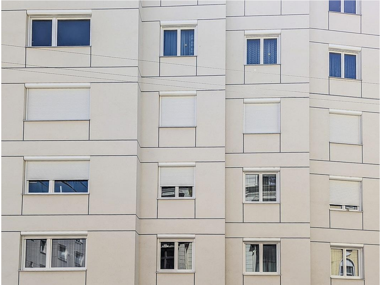
Bewilligungsfreie Rollläden an einem Wohngebäude der Nachkriegszeit mit glatter Fassade. Der eckige Vorbaukasten findet in der Fensterlaibung Platz, die Konstruktion sowie der Rollladen werden in Fensterfarbe gestaltet. Der Sonnenschutz ist an der Fassade einheitlich gestaltet.
