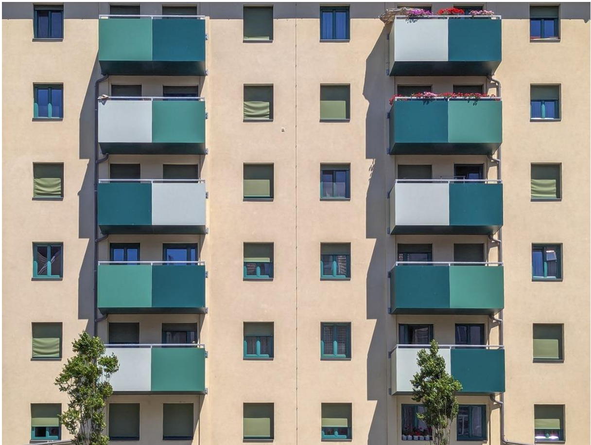
Bewilligungsfreie Senkrechtmarkisen an einem Wohngebäude der Nachkriegszeit außerhalb von Schutzzonen. Der Einbaukasten wurde im Zuge einer Fassadensanierung überputzt, die Konstruktion ist dadurch kaum sichtbar. Der Textilbehang ist farblich an die Fenster angelehnt. Der Sonnenschutz ist an der Fassade einheitlich gestaltet.
