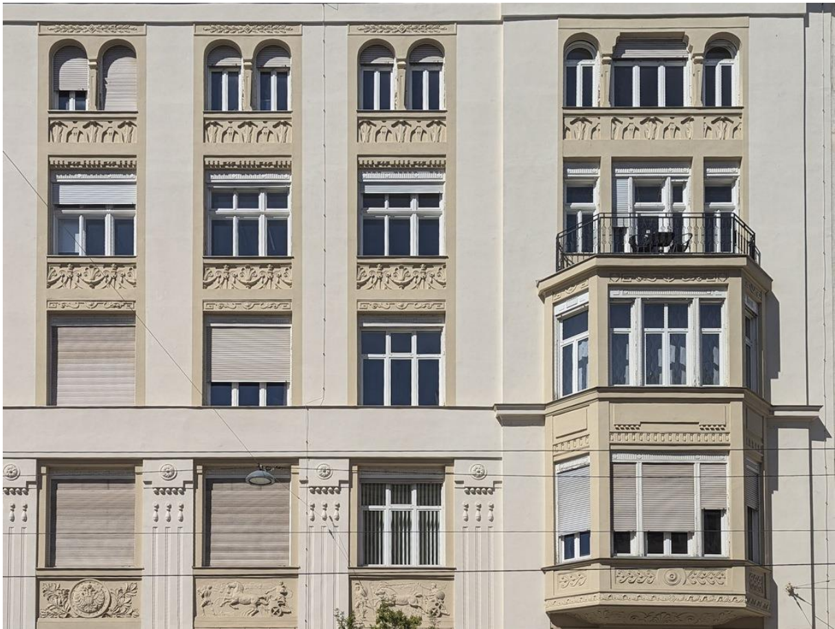
Rollläden an einem dekorierten Gründerzeithaus in einer Schutzzone. Der eckige Vorbaukasten findet in der Fensterlaibung der Kastenfenster Platz, die Konstruktion sowie der Rollladen werden in Fensterfarbe gestaltet. Der Vorbaukasten besitzt Ornamentik. Der Sonnenschutz ist an der Fassade einheitlich gestaltet.
