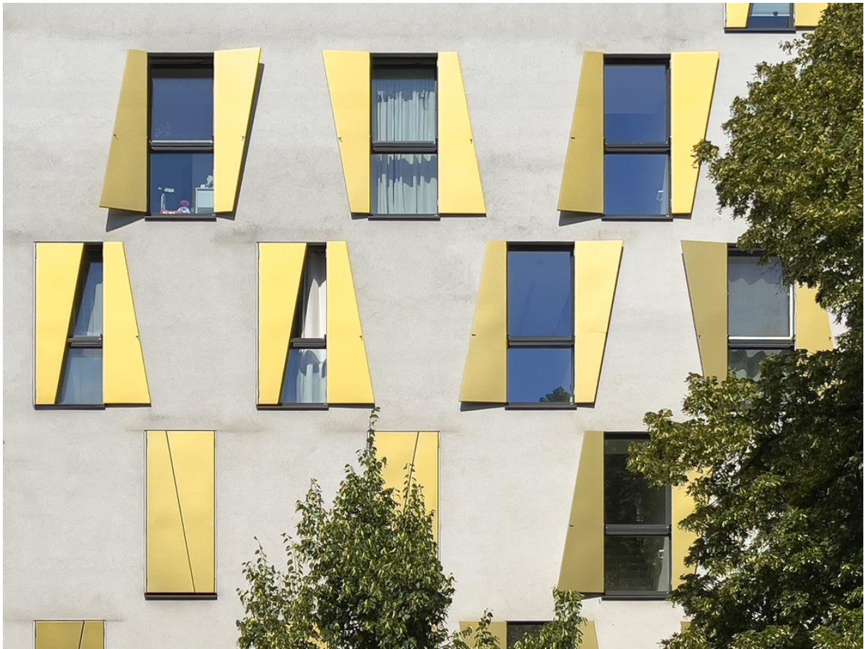
Klappläden an einem Neubau. Die Klappläden sind in Metall ausgeführt. Der Sonnenschutz ist an der Fassade einheitlich gestaltet.
