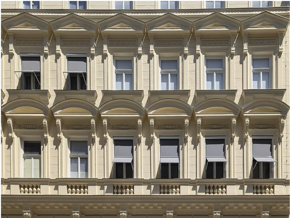
Markisoleetten an einem dekorierten Gründerzeithaus in einer Schutzzone. Der eckige Vorbaukasten findet in der Fensterlaibung der Kastenfenster Platz, die Konstruktion wird in Fensterfarbe ausgeführt. Der Textilbehang ist grau gestaltet. Die Sonnenschutzvorrichtungen an den einzelnen Fenstern des Hauses sind einheitlich nach diesem Prinzip gestaltet.
