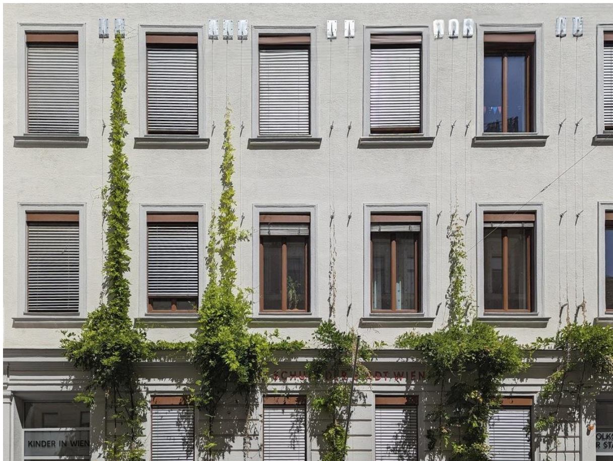
Raffstores an einem entdekorierten Gründerzeithaus in einer Schutzzone. Der eckige Vorbaukasten findet in der Fensterlaibung Platz, die Konstruktion wird in Fensterfarbe ausgeführt. Die Lamellen sind grau. Der Sonnenschutz ist an der Fassade einheitlich gestaltet.
