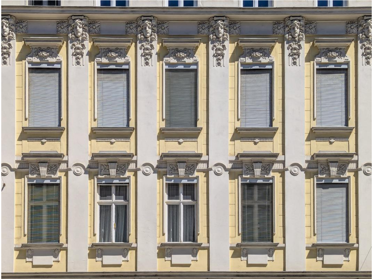
Bewilligungsfreie Raffstores an einem dekorierten Gründerzeithaus außerhalb von Schutzzonen. Der eckige Vorbaukasten findet in der Fensterlaibung der Kastenfenster Platz. Der Sonnenschutz ist an der Fassade einheitlich gestaltet.
