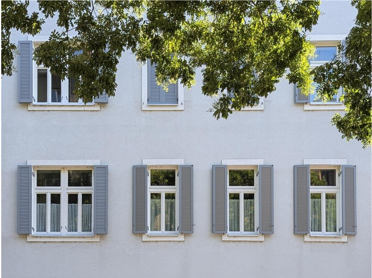
Bewilligungsfreie Klappläden an einem entdekorierten Gründerzeithaus außerhalb von Schutzzonen. Die Klappläden sind in einer Farbabstufung der Fassadenfarbe gestaltet. Der Sonnenschutz ist an der Fassade einheitlich gestaltet.
