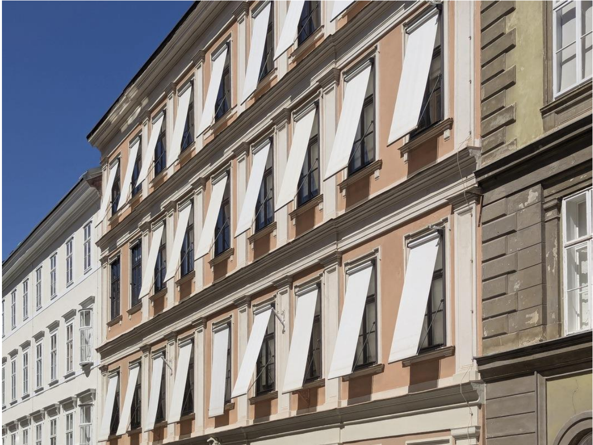
Fallarmmarkisen an einem dekorierten Gründerzeithaus in einer Schutzzone. Die Markisenrolle wird ohne Vorbaukasten vor dem Kastenfenster angebracht, die Konstruktion wird in Fensterfarbe ausgeführt. Der Textilbehang ist weiß gestaltet. Der Sonnenschutz ist an der Fassade einheitlich gestaltet.
