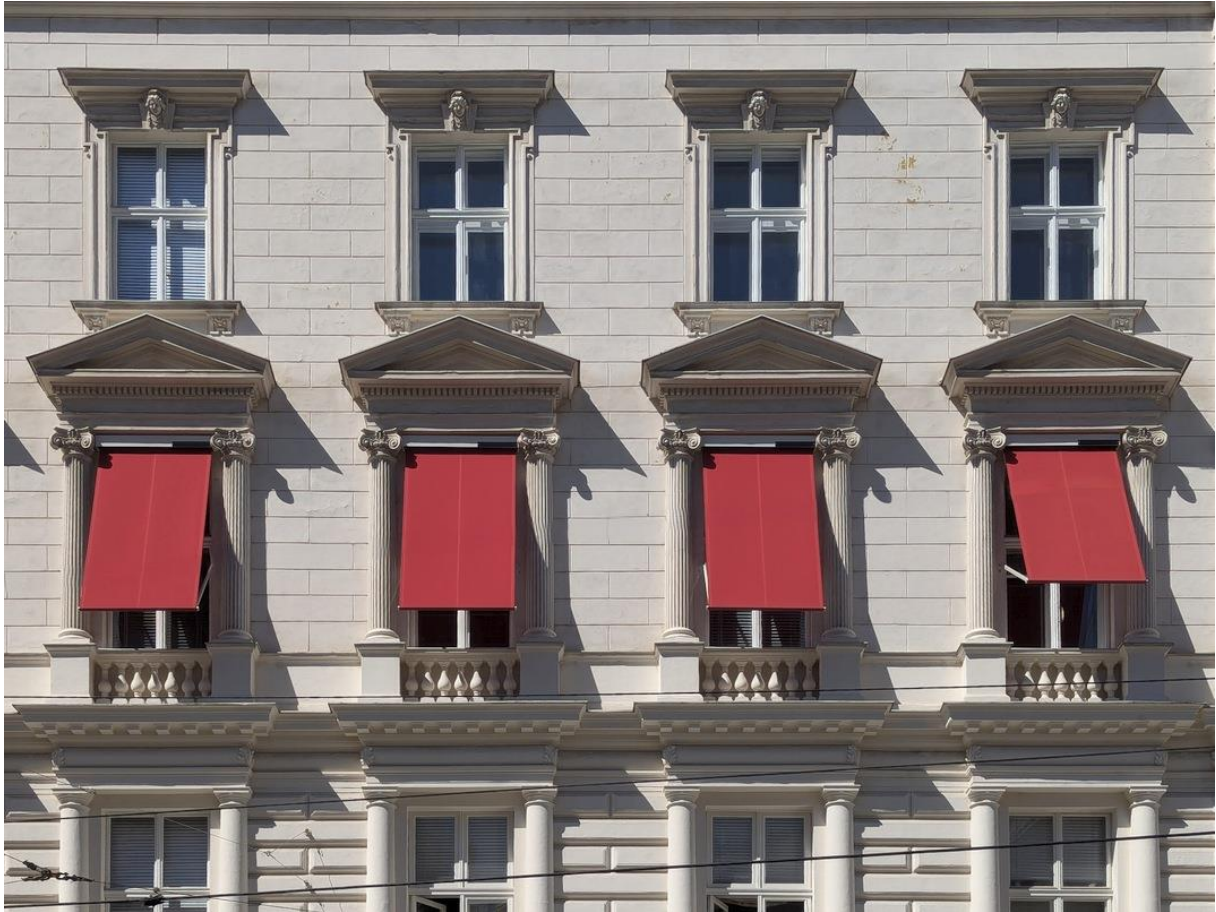
Fallarmmarkisen an einem dekorierten Gründerzeithaus in einer Schutzzone. Der eckige Vorbaukasten findet in der Fensterlaibung der Kastenfenster Platz, die Konstruktion wird in Fensterfarbe ausgeführt. Der Textilbehang ist farbig gestaltet. Die Sonnenschutzvorrichtungen an den einzelnen Fenstern des Hauses sind einheitlich nach diesem Prinzip gestaltet.
