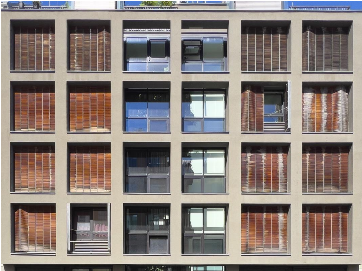
Faltläden an einem Neubau. Die Faltläden sind in Holz ausgeführt. Der Sonnenschutz ist an der Fassade einheitlich gestaltet.
